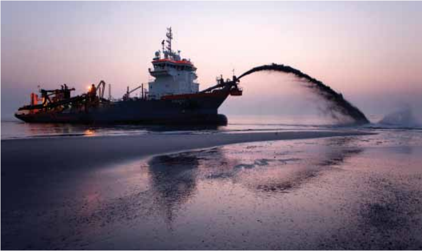
Zandmotor construction, April 2011. © Photo Jurriaan Brobbel, courtesy Rijkswaterstaat
